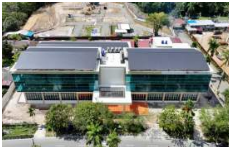
Gambar 3. 6 Pembangunan Gedung Gabungan DP3 dan Disdag Sumber : Tim Pengelola Data, Informasi dan Media Dinas Perkerjaan Umum Kota Balikpapan, 2025
