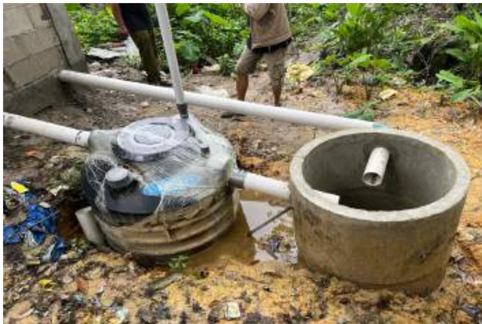
Gambar 3. 4 Pembangunan SPALDS Hibah Masyarakat Sumber : Tim Pengelola Data, Informasi dan Media Dinas Perkerjaan Umum Kota Balikpapan, 2025
