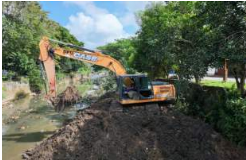
Gambar 3. 3 Pengerukan Sedimen Saluran/Normalisasi Sumber : Tim Pengelola Data, Informasi dan Media Dinas Perkerjaan Umum Kota Balikpapan, 2025
