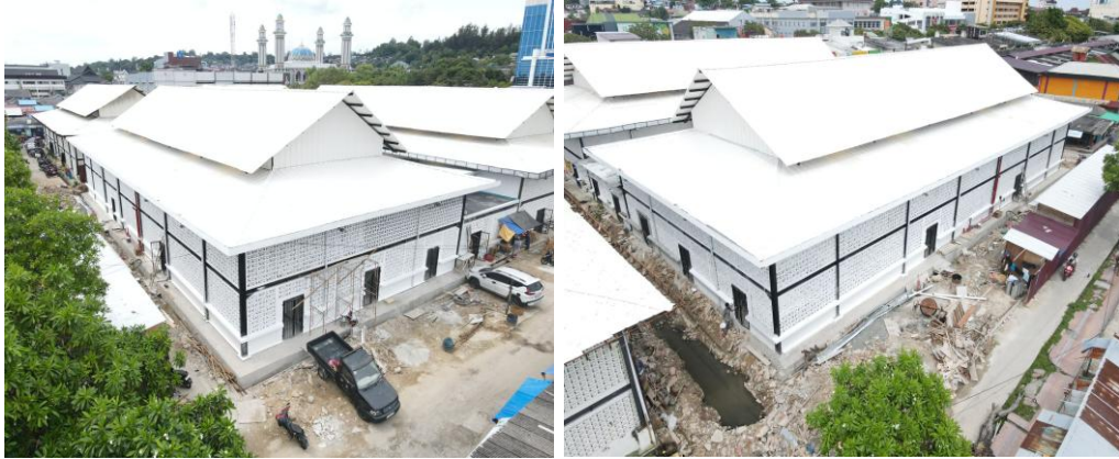
Gambar 24 Pembangunan Blok D Pasar Klandasan
