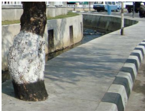
Bar Screen (Saringan Sampah) Bendali Tugu Adipura
