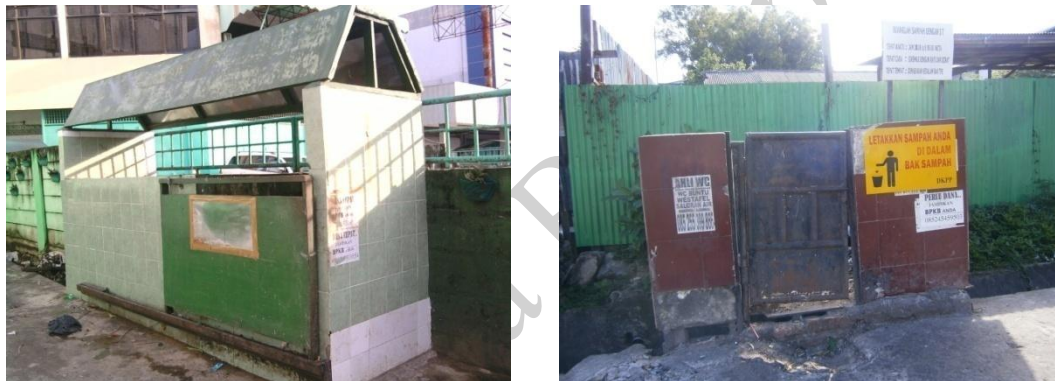
Gambar 3.29 Kondisi TPS Kota Balikpapan
