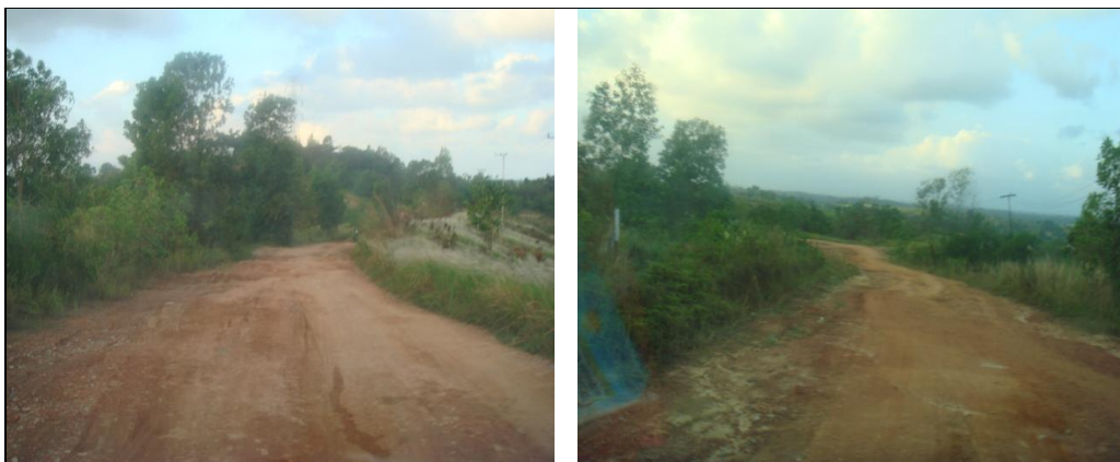
Gambar 3.4 Kondisi jalan menuju kawasan perumahan di Kelurahan Sepinggian dan Kondisi perumahan yang tidak berpenghuni
