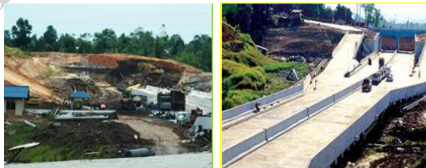
Gambar 1.2. Freeway (Jalan Tol) Penghubung Balikpapan – Samarinda
