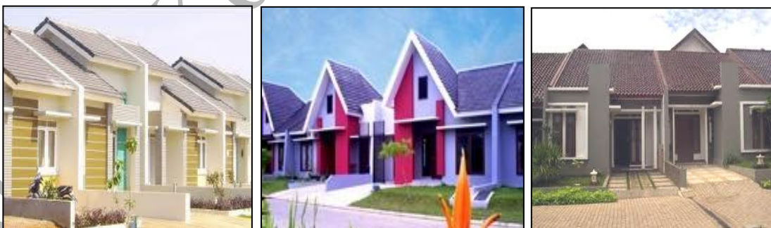
Gambar 3.12. Kondisi Permukiman Menengah
