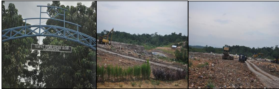
Gambar 3.37 Kondisi TPA Manggar
